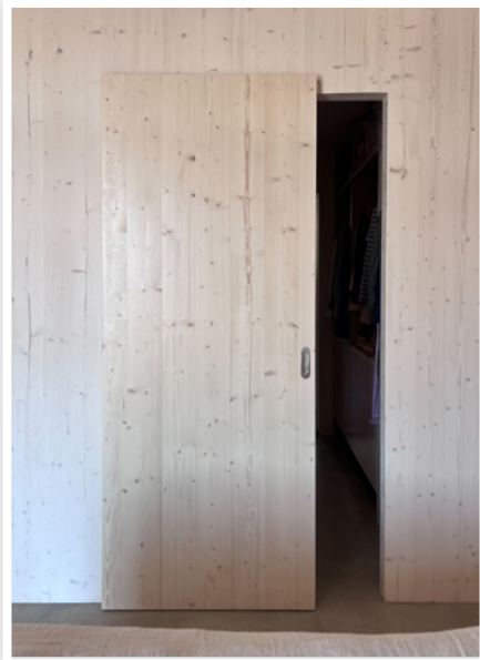
Pinta-asenteisessa liukuovessa kiskot ja pyörästö piiloutuu ovilehden ja seinän väliin.
